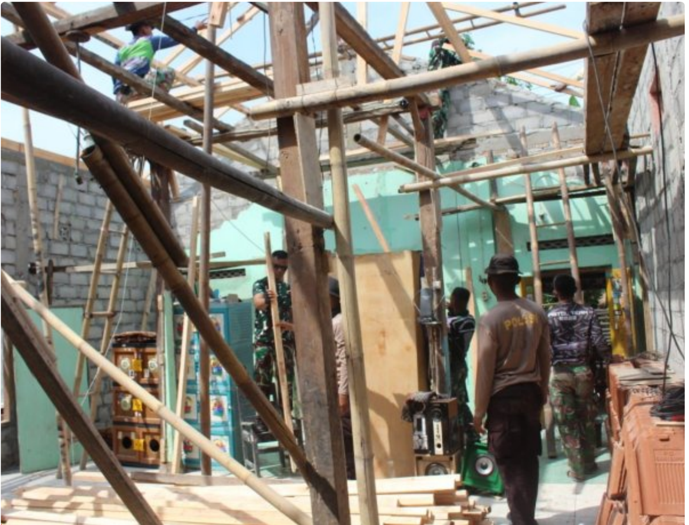
Rehab Rumah Tri Wijayanto Di Kebut Satgas TMMMD Reg 121
